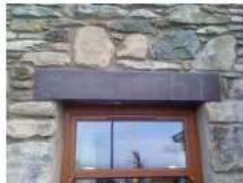
Dintel sobre ventana
