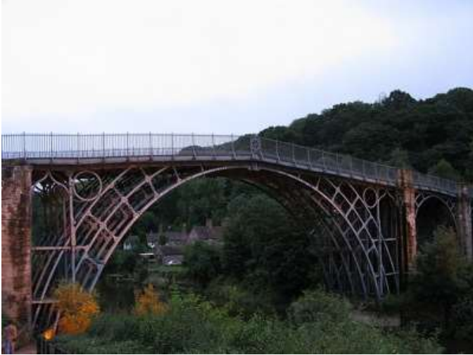
Puente con Estructura hiperestática
